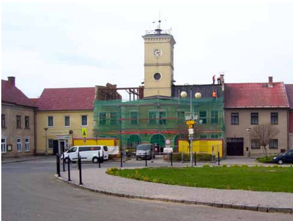
Během rekonstrukce bylo potřeba sundat střechu radnice a zcela vyměnit krovy. Foto J. Bernart
